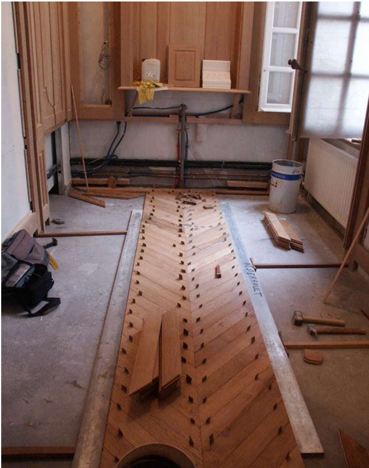
Instalación de tarima de roble en punta de hungría
