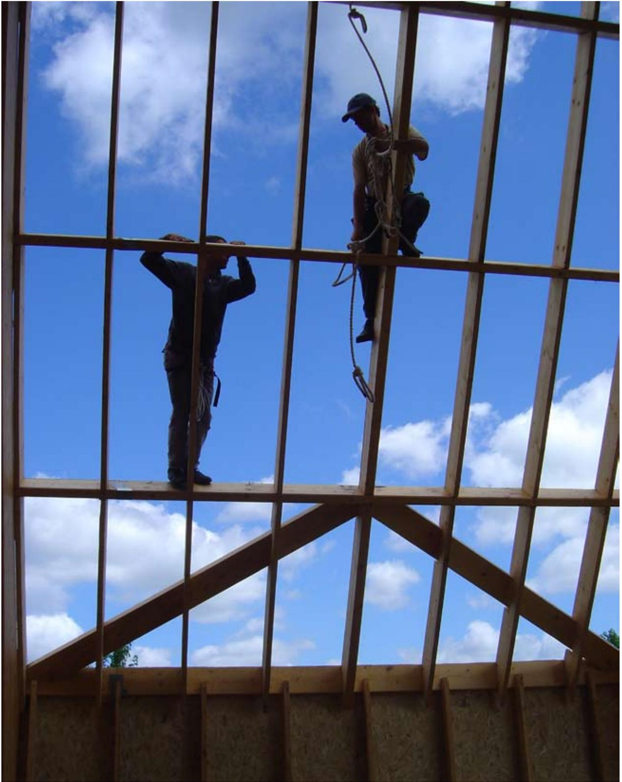
La luz máxima que puede alcanzar está en relación con el tipo estructural. El canto de la sección (h) puede estimarse en una primera aproximación en función de la luz (l), según la del tipo estructural. De manera aproximada la anchura de la sección (b) oscila entre  $h/5$  y  $h/8$ , con unos límites inferior y superior de 120 y 220 mm respectivamente.
