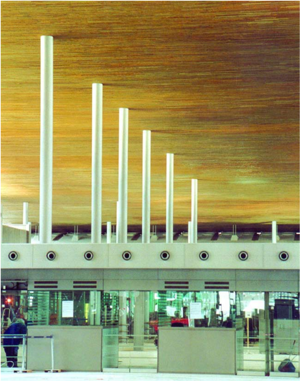
Techo de madera de Ayous tratada para ignifugar en el aeropuerto Charles de Gaulle en Roissy (Francia). Arquitecto: Paul Andreu
