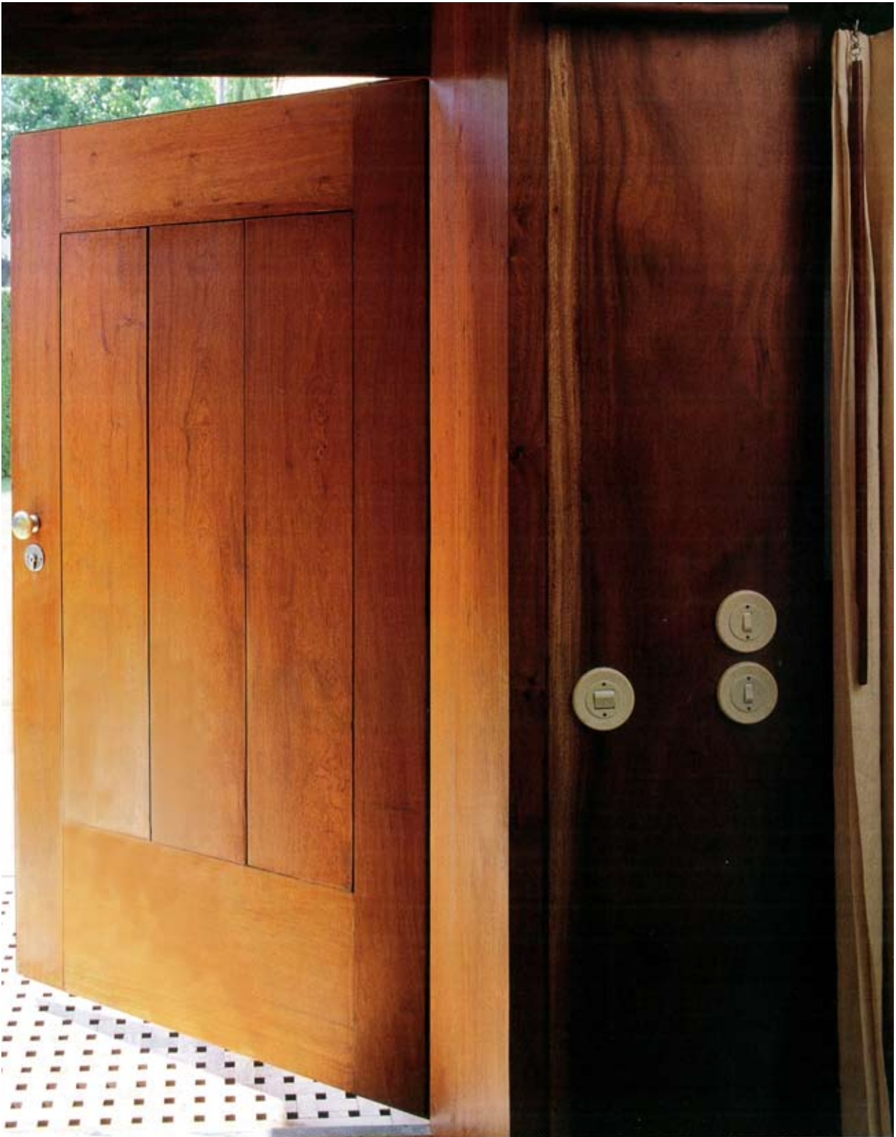
Puerta entablada en la casa Ferreira da Costa. Arquitecto: Álvaro Siza
