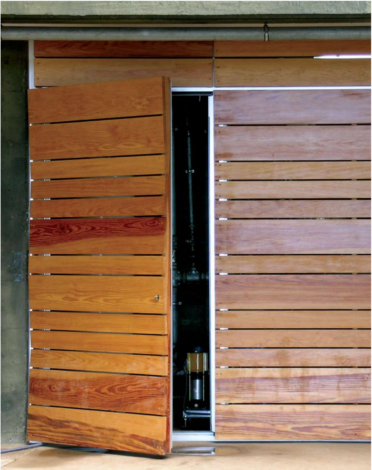
Puerta entablada en el Instituto de la Orotava (Tenerife). Arquitectos: AmP Arquitectos
