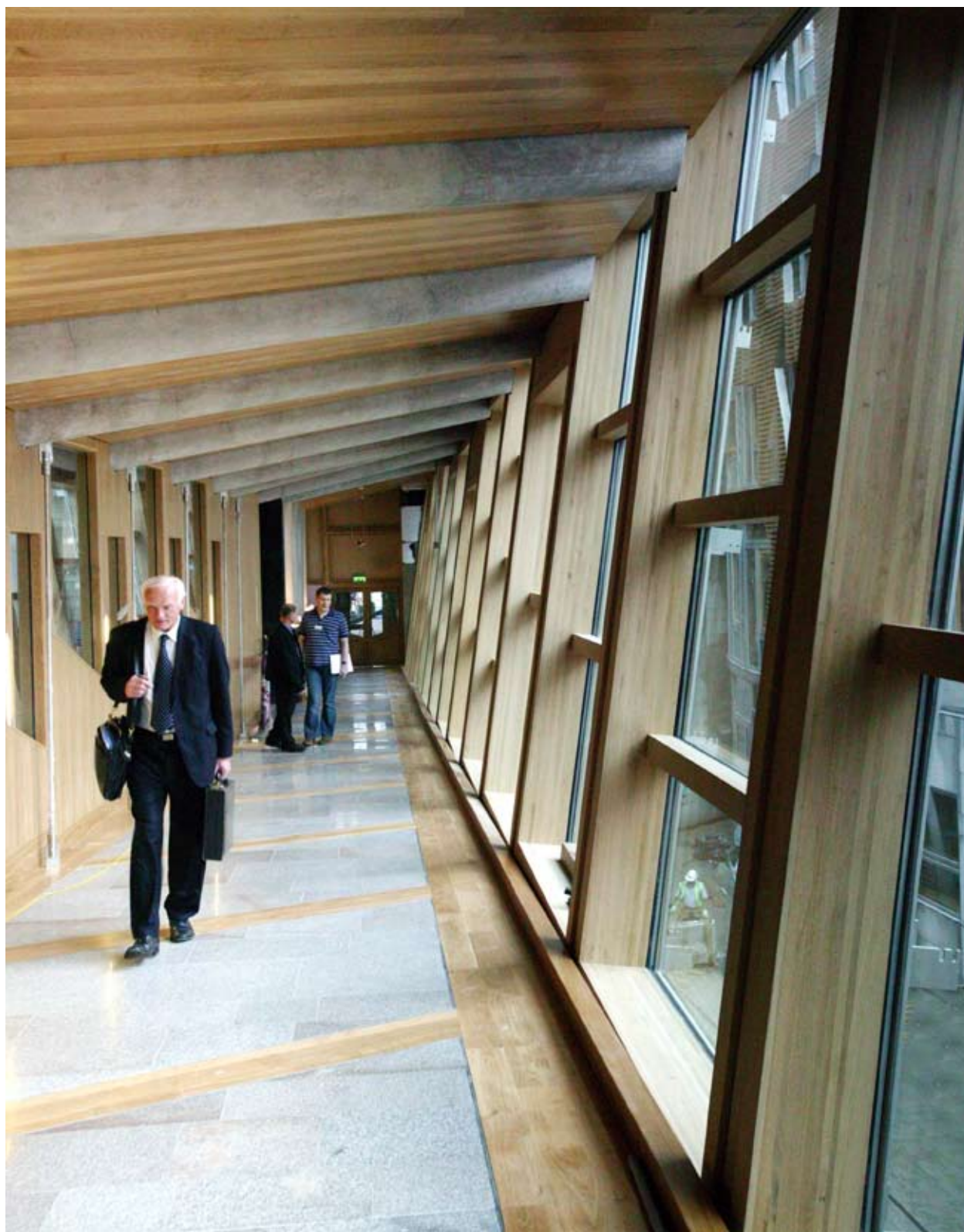
Muro cortina de madera laminada en el Parlamento de Escocia. EMT Arquitectos
